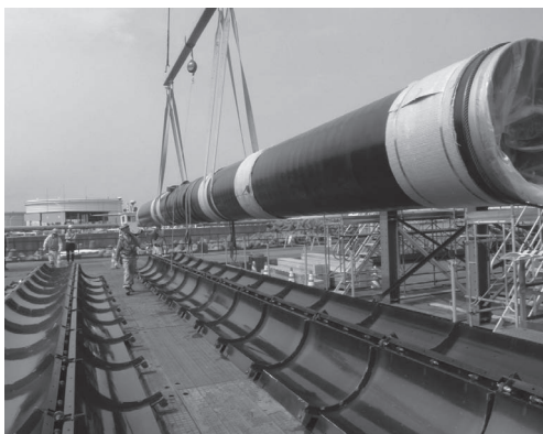
図-2 配管吊込み作業
