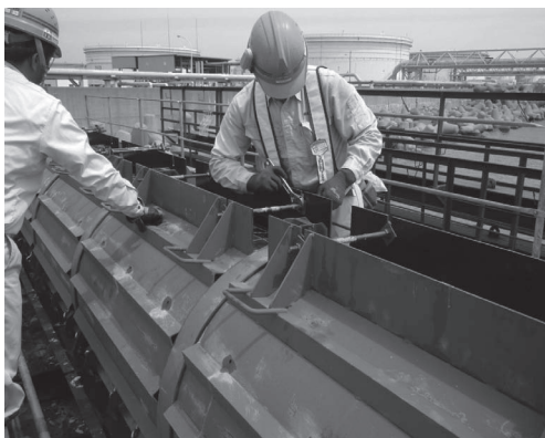
図-3 型枠設置および調整
