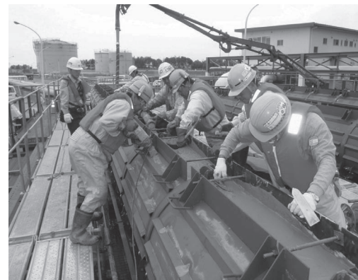
図-4 鉄筋工、コンクリート工
