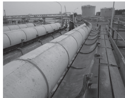
図-5 脱型、移設(3本製造)
