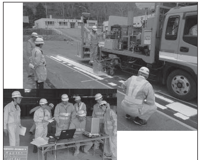
図-2 発注者立会による キャリブレーション実施状況
