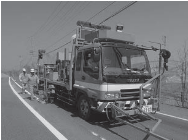
図-1 小樽地区での区画線施工状況
