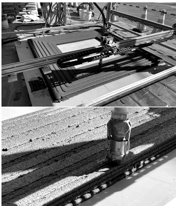
図-6 3DP積層（印刷）状況
