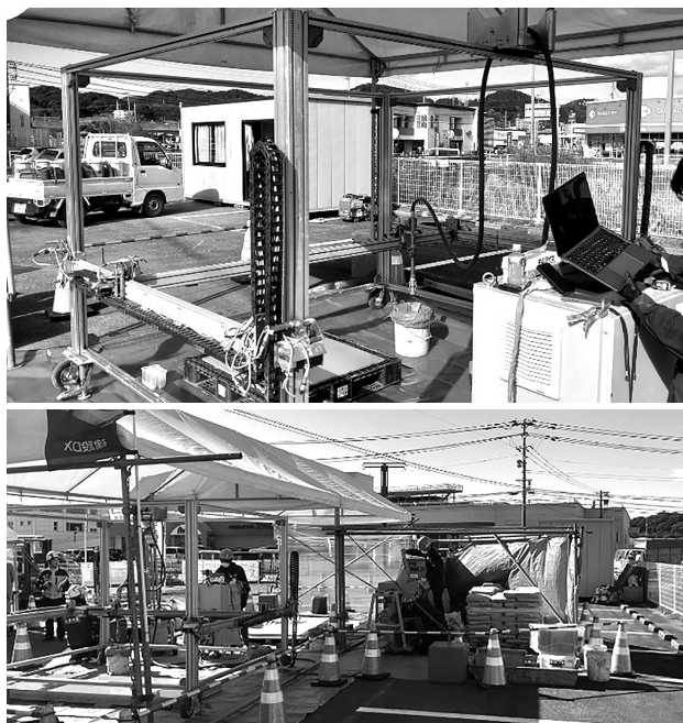
図-4 3DP設置・設定作業
