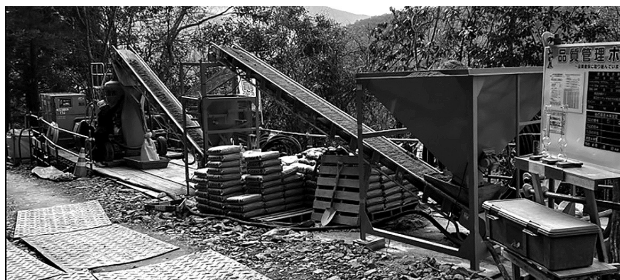
図-3 吹付プラント（従来施工）
