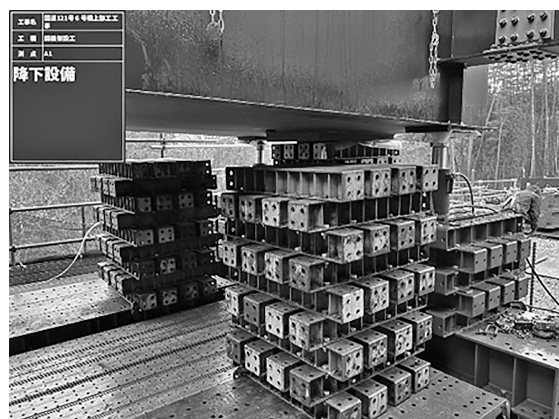
図-2 桁受け設備
