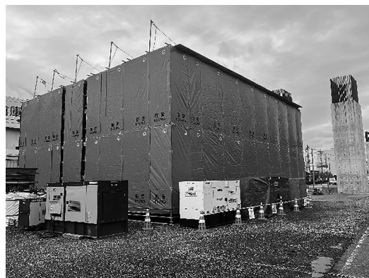
図-3 地組立時の風防設備
