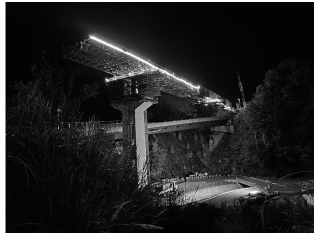
図-10 送出し施工状況
