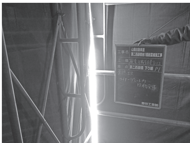
図-4 テープ式ライト（LED）設置状況
