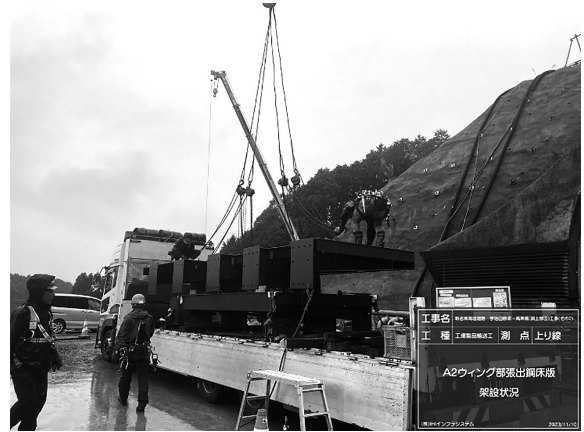
図-5 橋台躯体付き張り出し鋼床版
