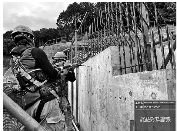
図-6 橋台躯体削孔状況
