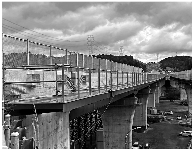
図-11 張り出し鋼床版施工完了
