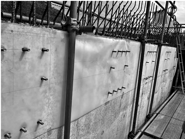
図-7 フィルム設置状況
