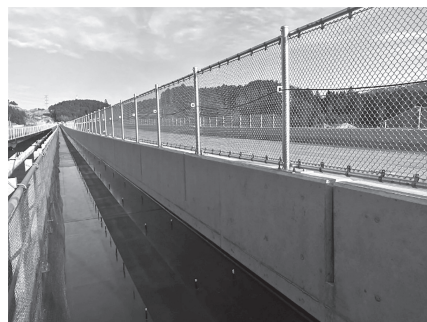
図-3 橋梁区間の張り出し鋼床版
