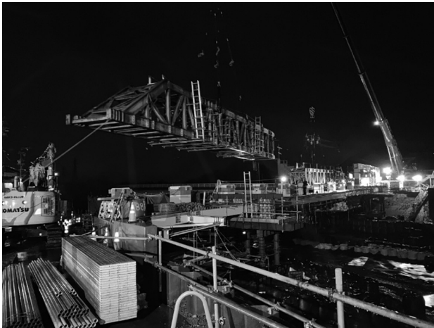
図-7 エレクショントラス架設状況
