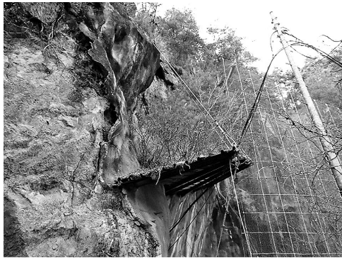
図-5 既設吹付面剥落、防護柵堆積物
