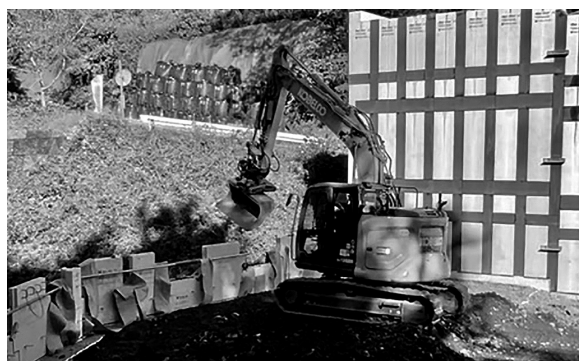
図-8 補強土壁工におけるワンマン施工
