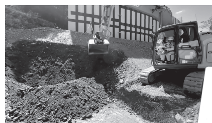
図-7 擁壁床掘状況
