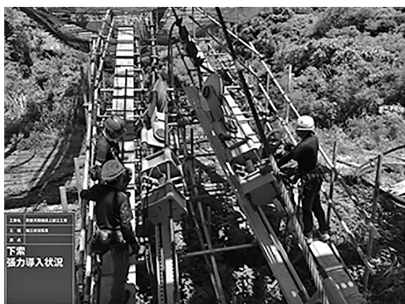
図-3 下索張力調整状況
