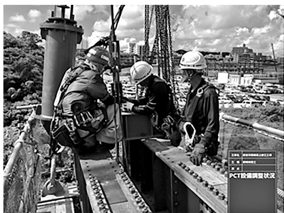
図-4 吊索張力調整状況
