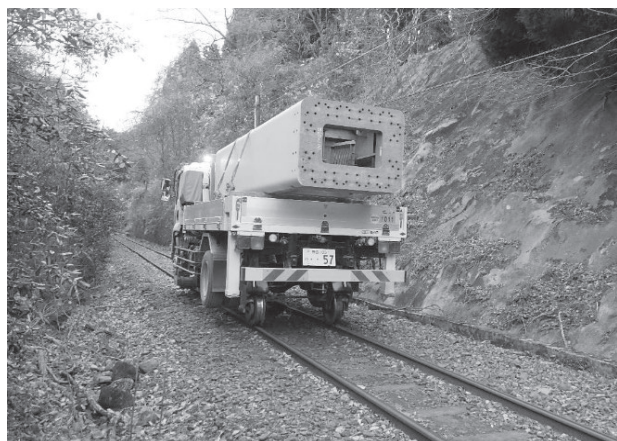
図-3 鉄塔柱部材運搬状況
