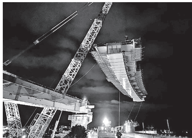
図-10 大ブロック桁架設状況
