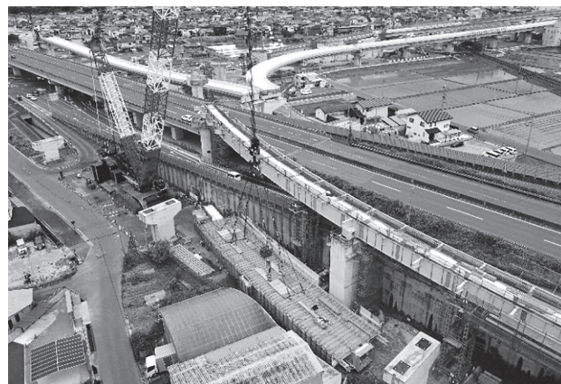
図-9 大ブロック桁地組立状況
