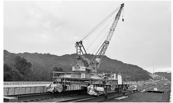
図-6 桁上ジブクレーン
