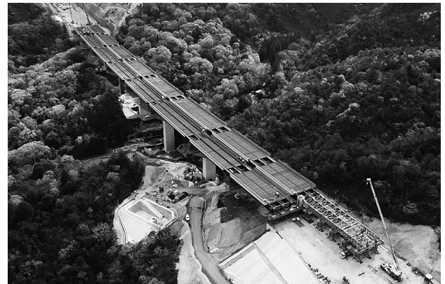
図-7 送出し完了時全景
