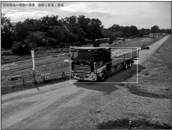
図-3 AIカメラによる納入管理
