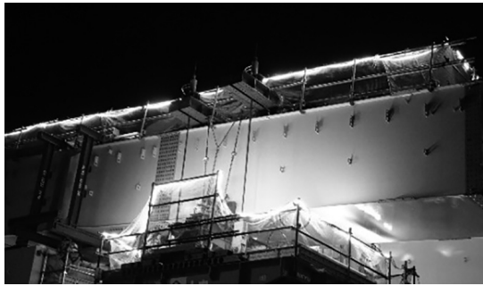
図-7 桁固定状況
