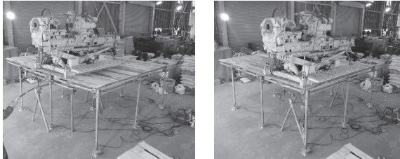
図-7 足場端部へのマシン設置
