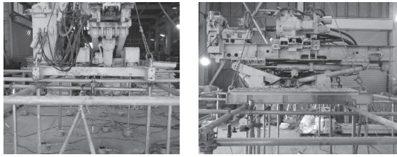
図-8 マシン幅より建地間隔が広い場合
