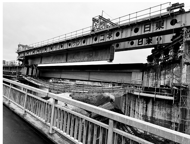
図-4 主桁架設作業状況
