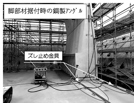
図-5 ズレ止め金具設置状況
