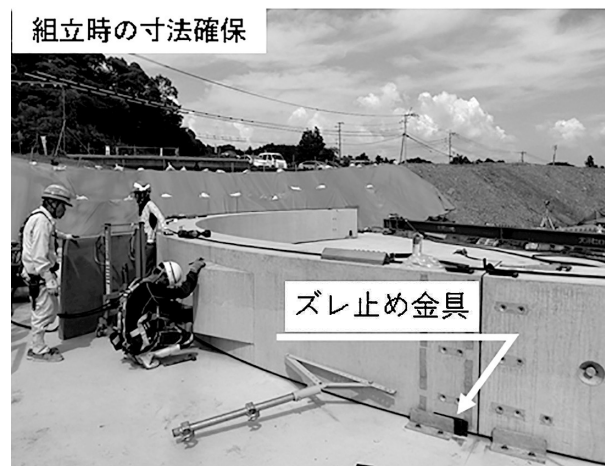
図-2 接合部ズレ止め金具
