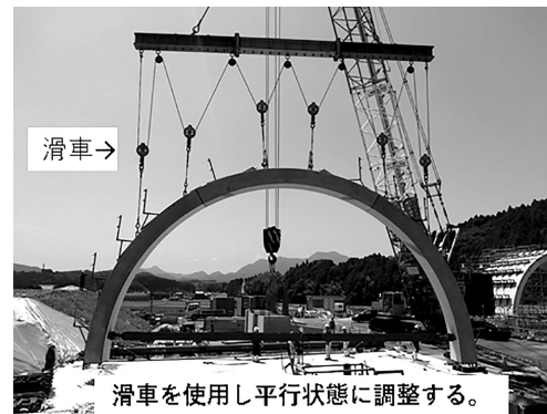
図-4 アーチ部吊上げ状況
