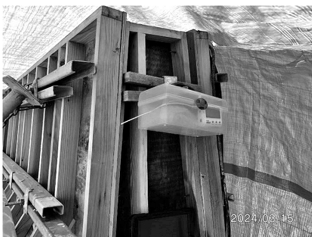
図-6 コンクリート養生 温湿度計測状況
