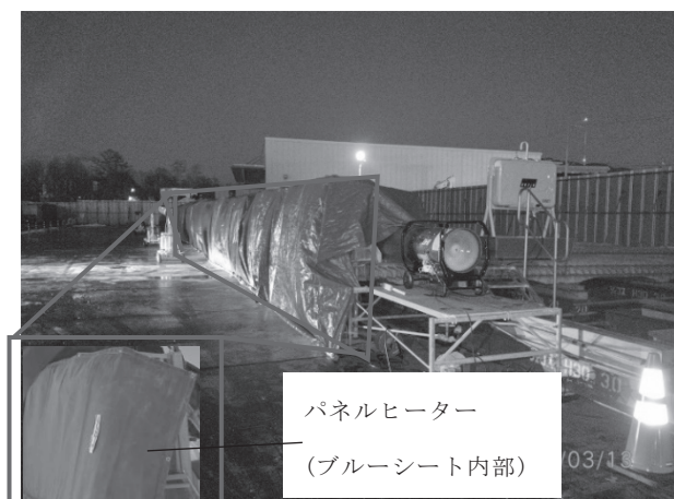
図-5 打設後 給熱養生状況
