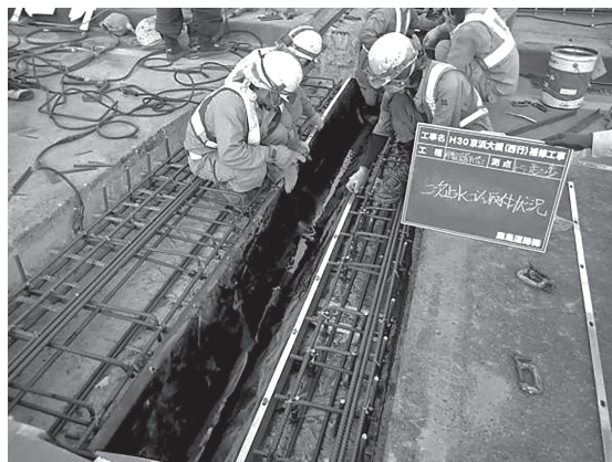
図-10 二次止水材(排水ゴム樋)の取付
