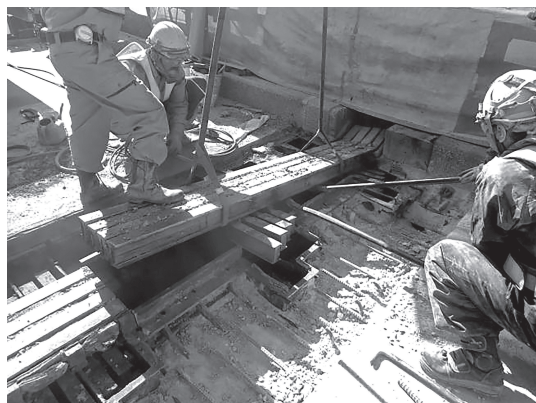
図-8 ビーム型ジョイント撤去
