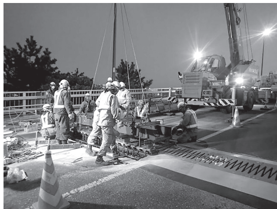
図-11 アルミ製ジョイントの据付
