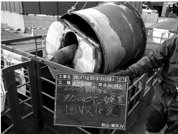
図-8 既設人孔側壁 削孔コア回収状況
