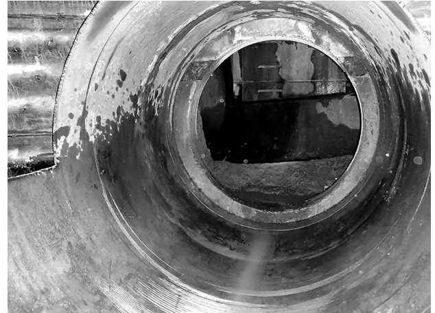
図-9 既設矩形マンホール到達状況
