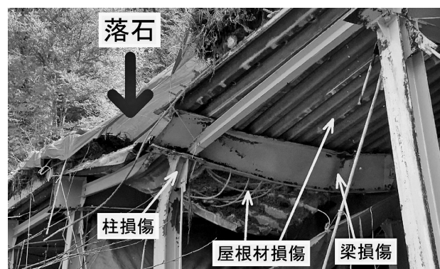
図-1 スノーシェッド損傷状況
