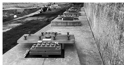
図-5 支承据え付け完了（A1橋台）
