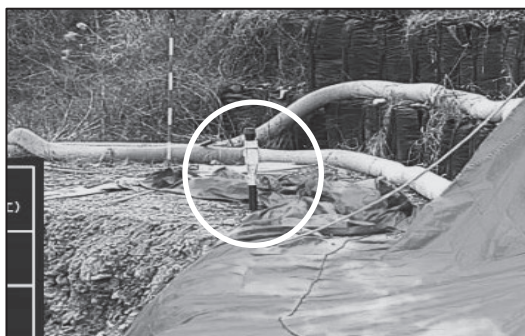
図-5 センサー杭設置状況
