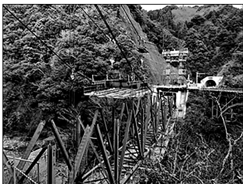
図-3 上弦材架設状況
