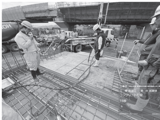
図-2 試験体打設
