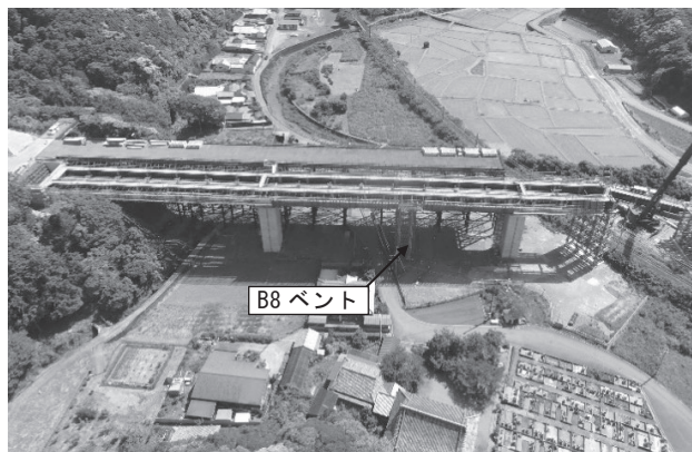
図-4 ベント設備先行解体状況
