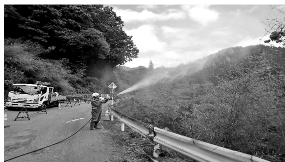
図-6 粉塵対策散水状況
