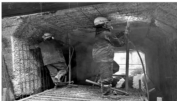
図-4 上向きでののはつり作業状況
