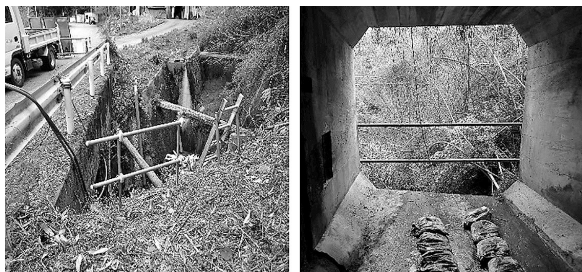
図-5 落下防止柵設置
