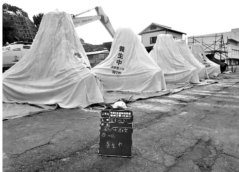
図-3 コマシート使用状況
