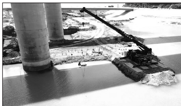
図-3 根固めブロック水中施工状況
