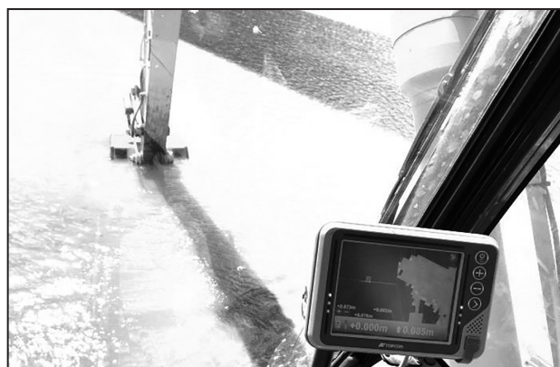
図-4 ICT床掘状況+モニター画面
