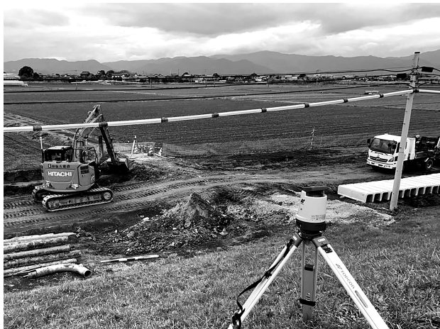
図-2 杭ナビショベルによる施工状況
