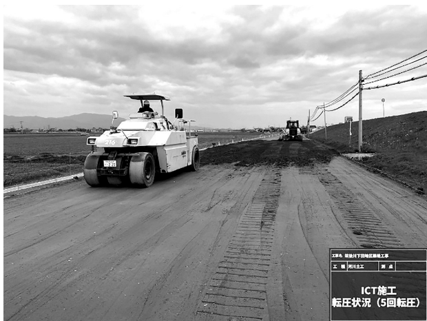
図-3 盛土施工状況
