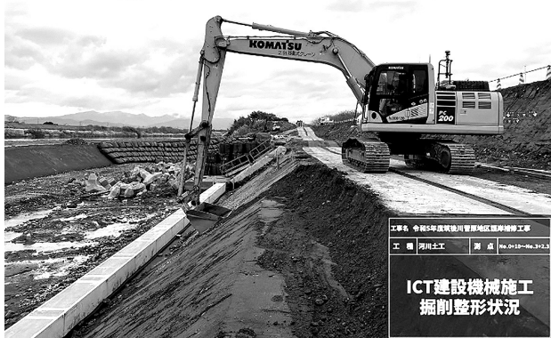
図-2 ICT建設機械による施工状況
