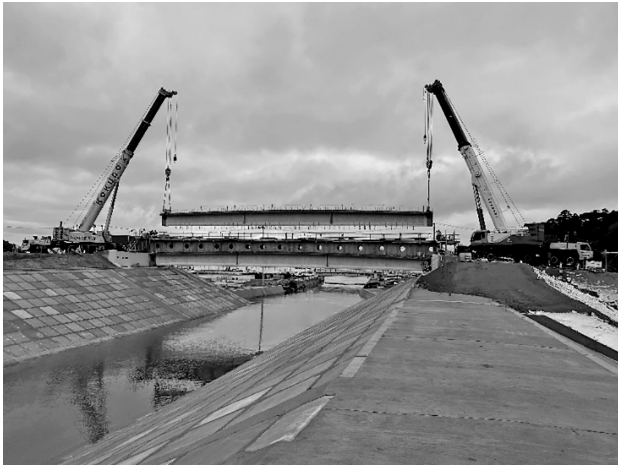
図-2 主桁架設作業状況
