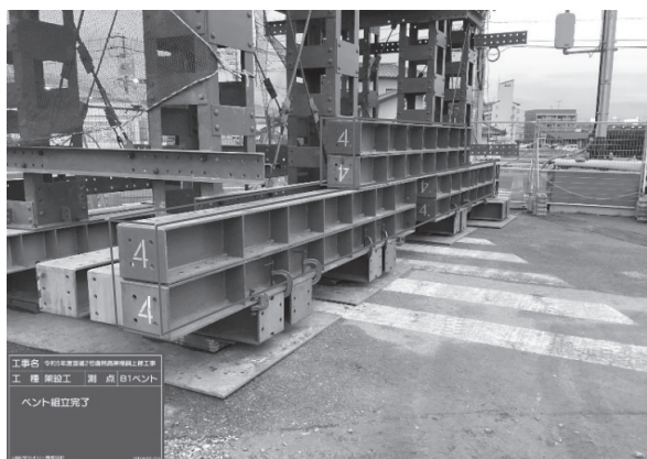
図-3 ベント転倒防止設備
