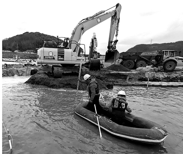
図-1 水中部の出来形計測の様子
