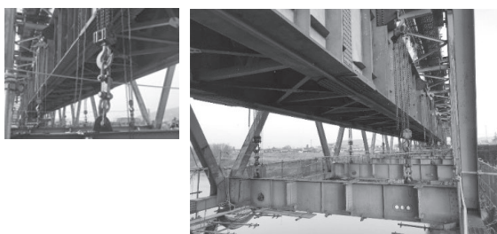
図-2 応力解放状況および張力管理状況
