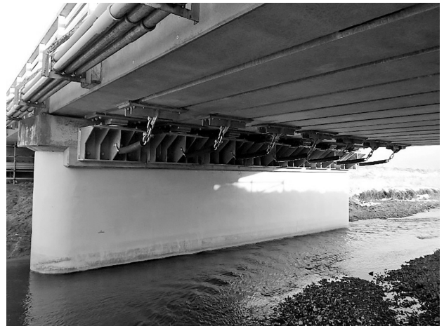
図-4 長沖橋完成（ブラケット取り付け完了）
