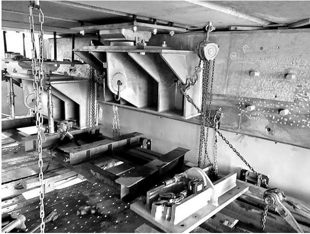
図-2 アンカー、ブラケット設置
