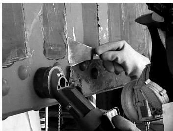
図-7 リベットを含む特殊部の塗膜剥離作業状況
