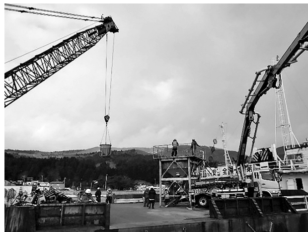
図-4 グラントホッパーを用いた打設状況
