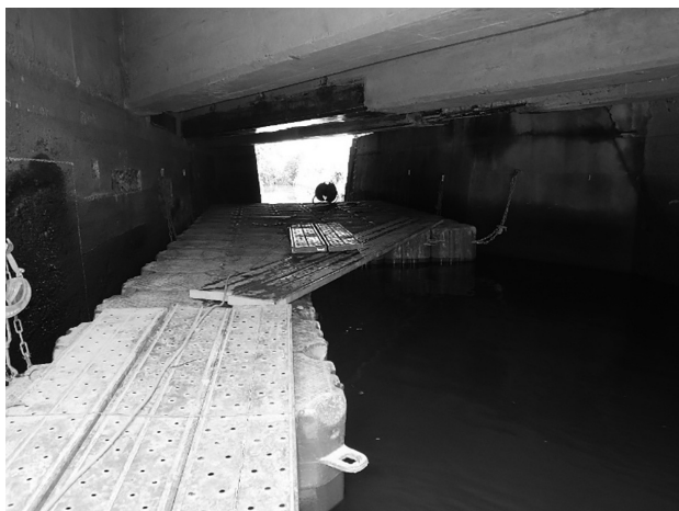
図-3 ピアフロートによる作業状況
