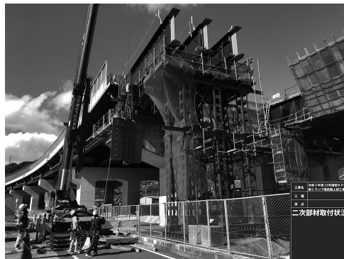
図-2 単材架設
