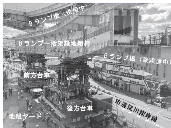
図-1 桁地組完了架設前
