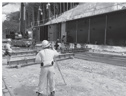
図-4 地組桁の出来形精度管理状況
