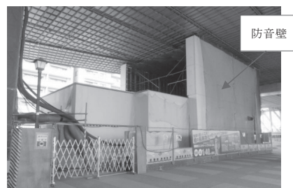
図-5 ブラスト後方設備の防音壁
