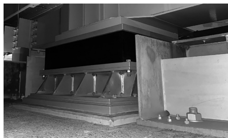
図-6 P2橋脚支承取替完了
