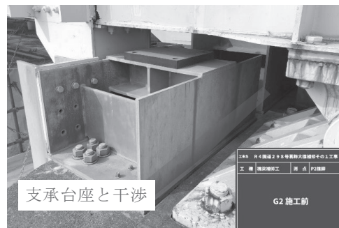
図-1 P2橋脚支承周辺の既設耐震補強部材
