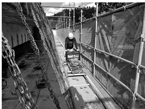
図-4 台車レール使用状況
