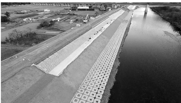
図-3 高水護岸部 完了（覆土前）
