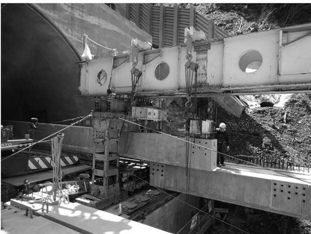
図-3 主桁引き出し状況
