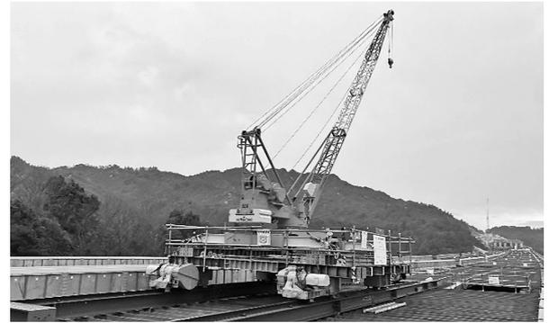
図-6 桁上ジブクレーン
