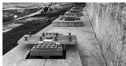
**図-5 支承据え付け完了 (A1橋台)**
