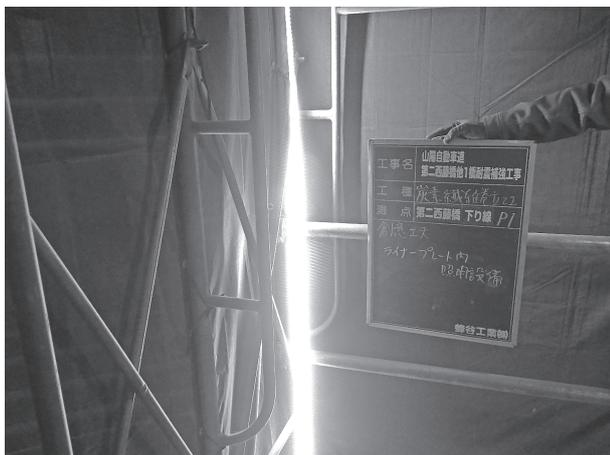
図-4 テープ式ライト (LED) 設置状況
