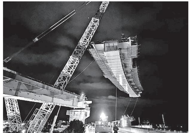
図-10 大ブロック桁架設状況
