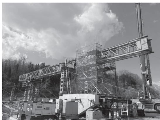
**図-2 1径間目ガーダー組立て要領図及び施工状況写真**
