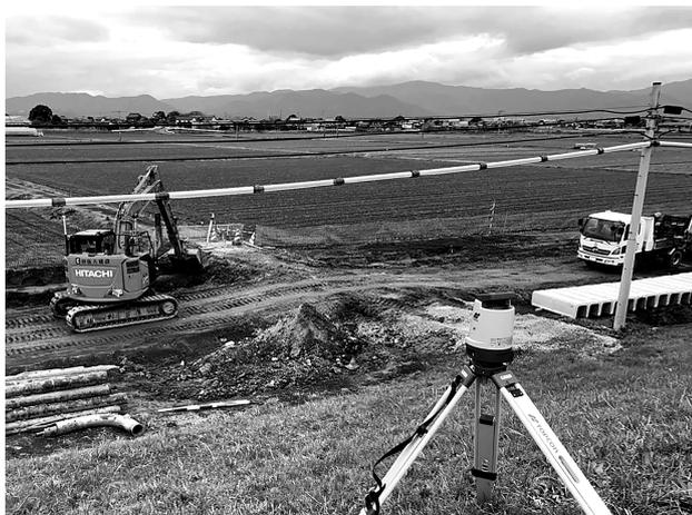
図-2 杭ナビショベルによる施工状況
