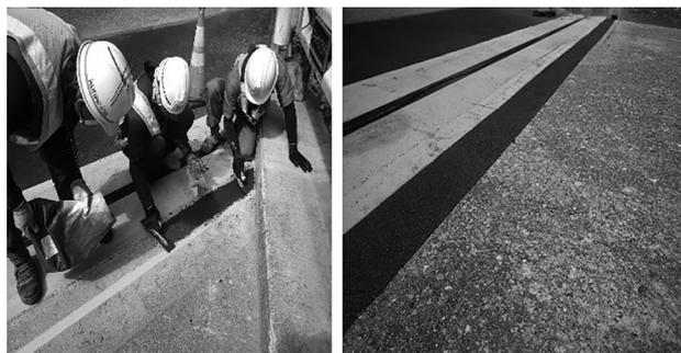
図-2 伸縮装置設置後の段差解消
