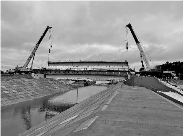
図-2 主桁架設作業状況
