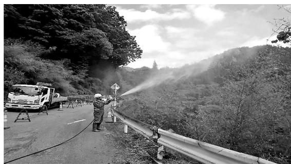
図-6 粉塵対策散水状況
