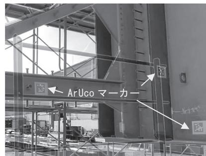
**図-2** ARシステムによる重畳例
