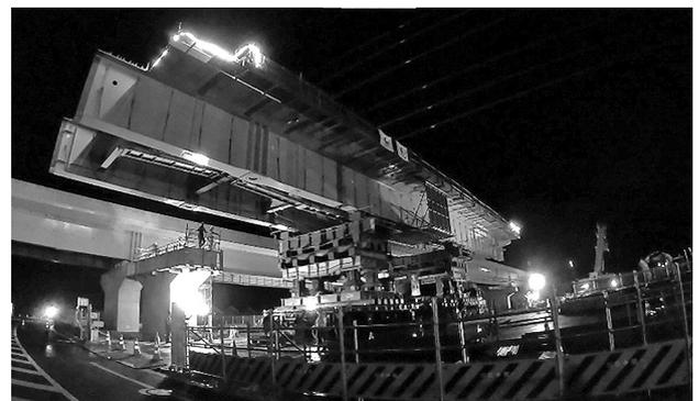
図-1 多軸式特殊台車による一括架設
