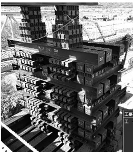
図-6 降下設備組立状況
