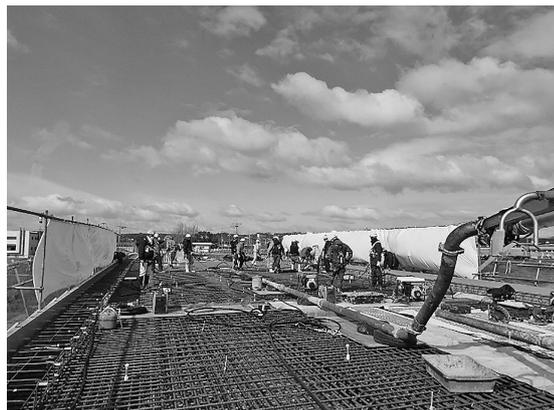
図-3 風防設備設置状況
