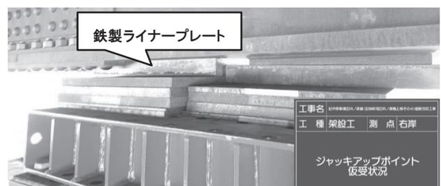
図-5 鉄製ライナープレート使用図
