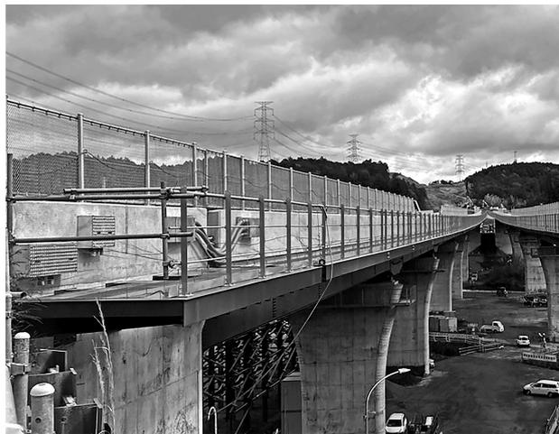
図-11 張り出し鋼床版施工完了
