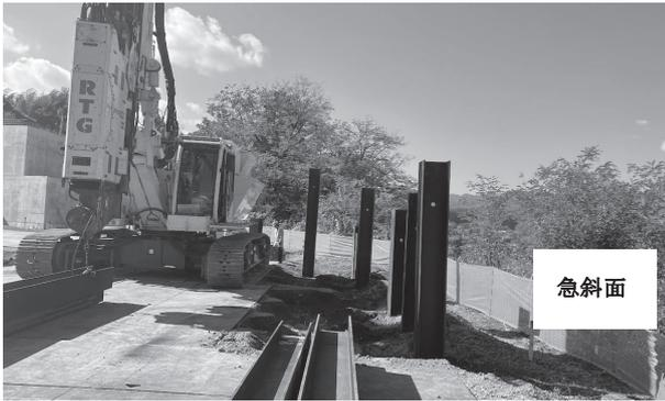
図-5 H鋼杭打設状況
