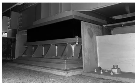
図-6 P2橋脚支承取替完了
