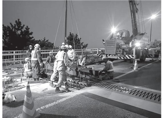
図-11 アルミ製ジョイントの据付
