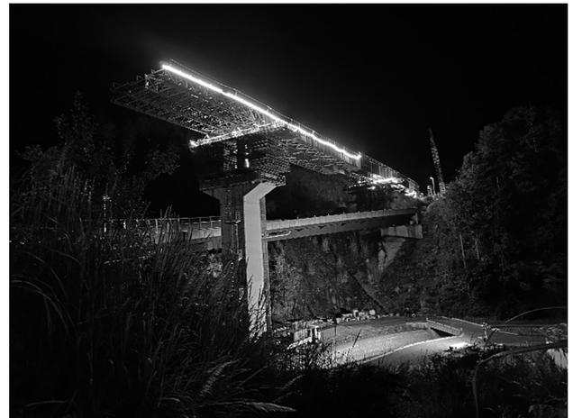
図-10 送出し施工状況
