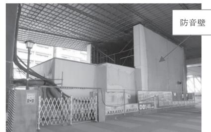
図-5 ブラスト後方設備の防音壁
