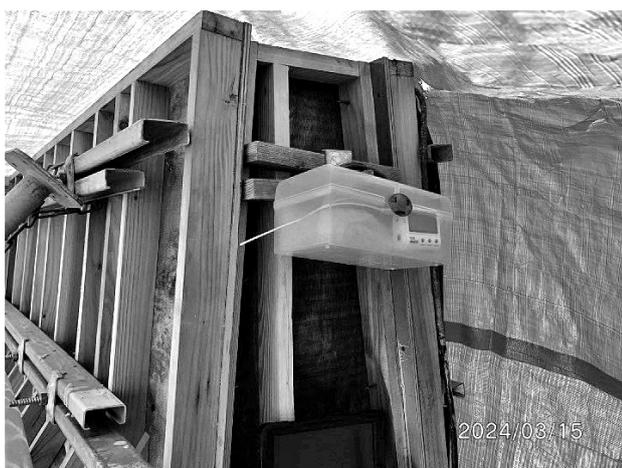
図-6 コンクリート養生 温湿度計測状況
