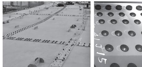
図-3 現場継手（左：鋼床版，右：主桁ウェブ）
