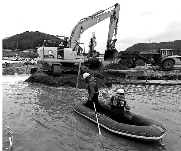
図-1 水中部の出来形計測の様子
