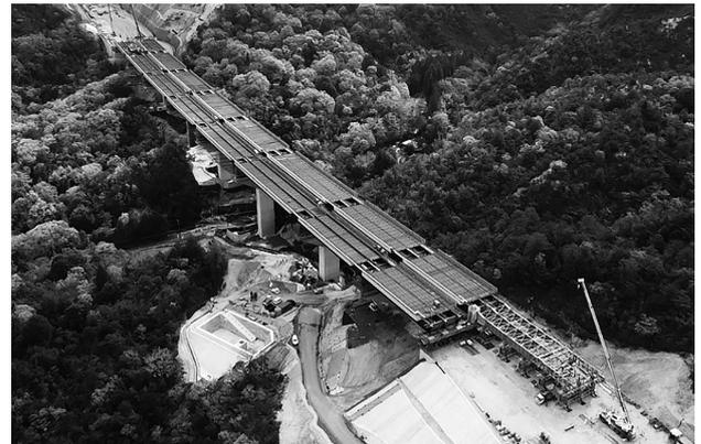
図-7 送出し完了時全景
