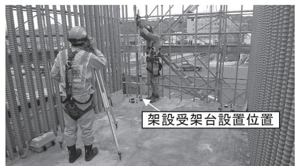
図-11 既設コンクリート支柱計測状況
