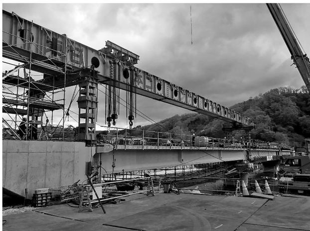
図-6 主桁架設完了（3径間）
