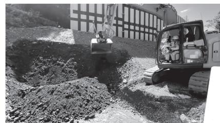
図-7 擁壁床掘状況
