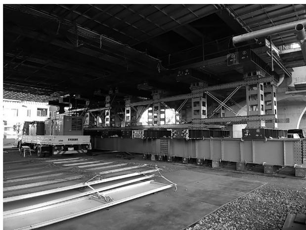
**図-2** ベントによるジャッキアップ設備
