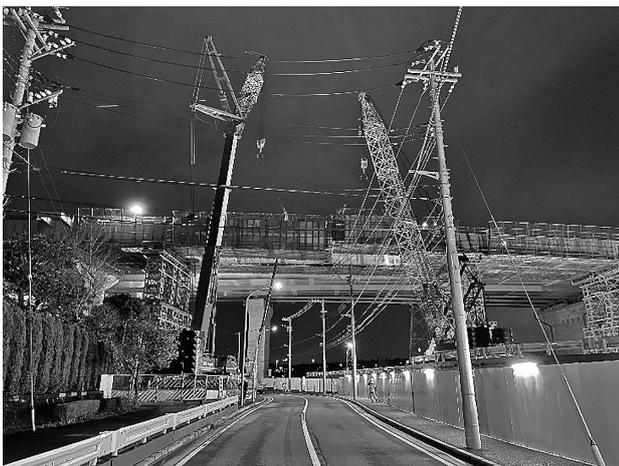
図-3 夜間落とし込み架設状況
