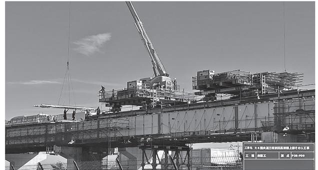
図-3 桁上クレーンによる合成床版架設
