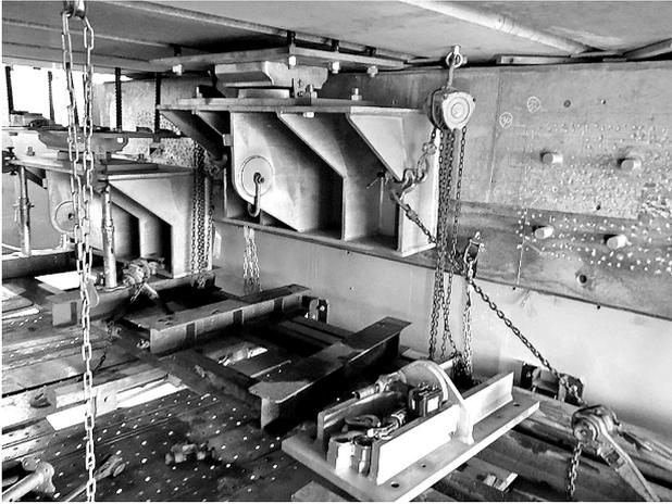
図-2 アンカー、ブラケット設置
