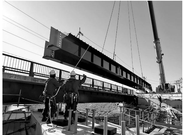
図-6 主桁撤去作業状況
