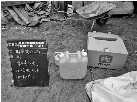
図-3 油専用吸着材「ピグマット」
