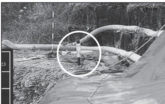
図-5 センサー杭設置状況
