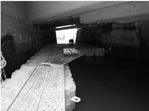
図-3 ピアフロートによる作業状況
