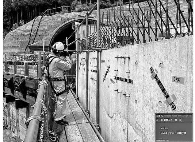
図-8 工業計測用高性能カメラによる計測状況
