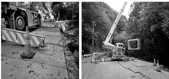
図-3 作業スペース確保、BOX吊上げ作業状況
