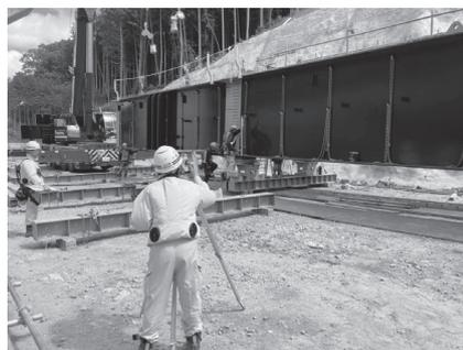
図-4 地組桁の出来形精度管理状況
