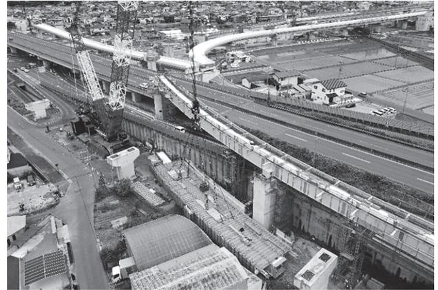
図-9 大ブロック桁地組立状況
