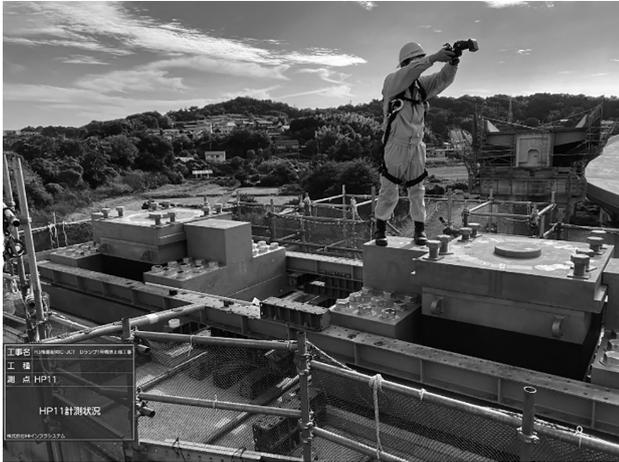
図-5 カメラ計測実施状況
