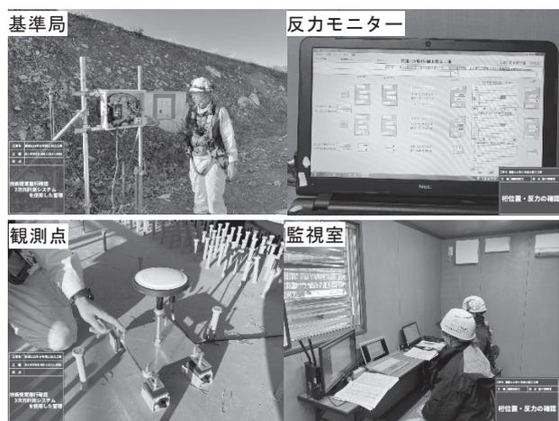
図-3 桁位置・反力の監視システム
