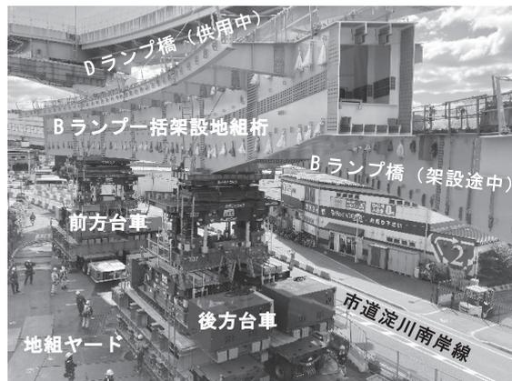
図-1 桁地組完了架設前
