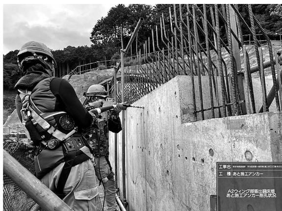
図-6 橋台躯体削孔状況
