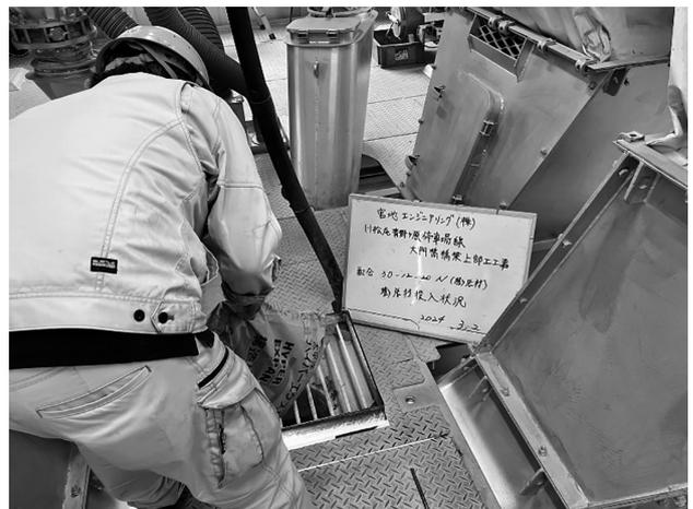
図-2 膨張材投入状況
