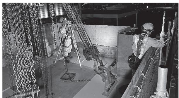
図-12 夜間架設時天端高さ計測状況
