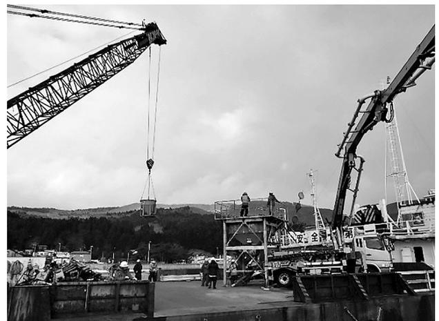
図-4 グラウンドホッパーを用いた打設状況
