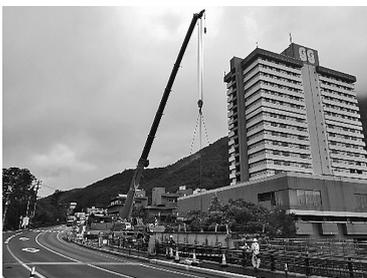
図-2 側径間主桁撤去状況
