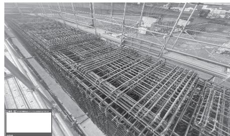
鉄筋径 D22~35 平均ピッチ 150mm 標準隙間 128mm
