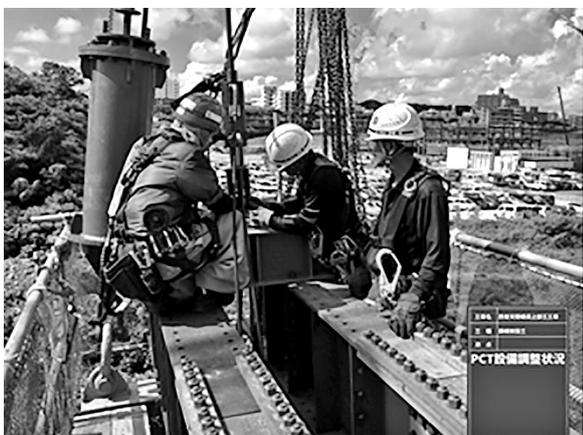
図-4 吊索張力調整状況
