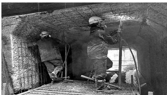
図-4 上向きでののはつり作業状況
