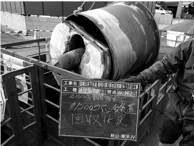
図-8 既設人孔側壁 削孔コア回収状況
