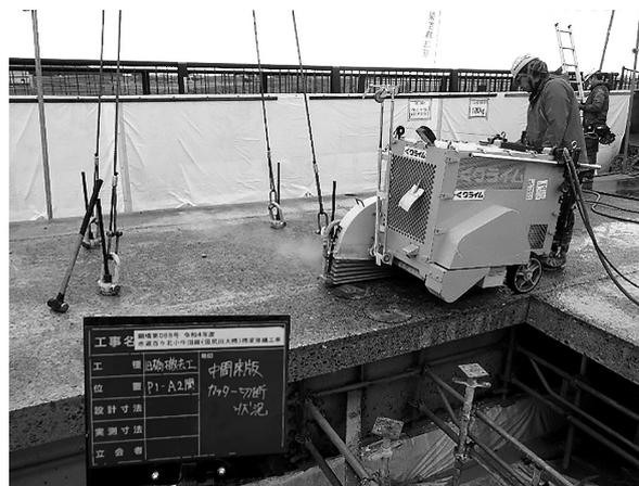
図-2 床版切断作業状況
