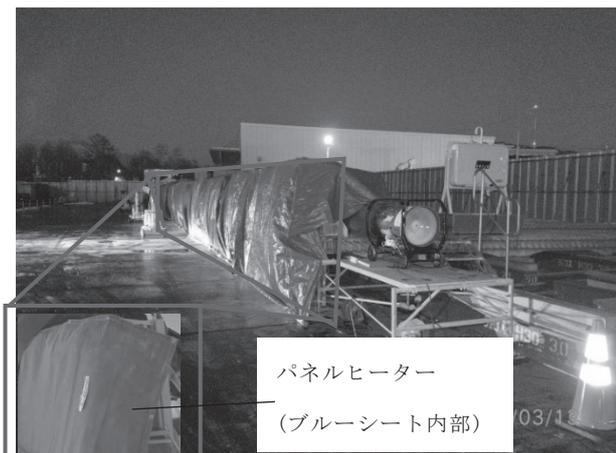
図-5 打設後 給熱養生状況
