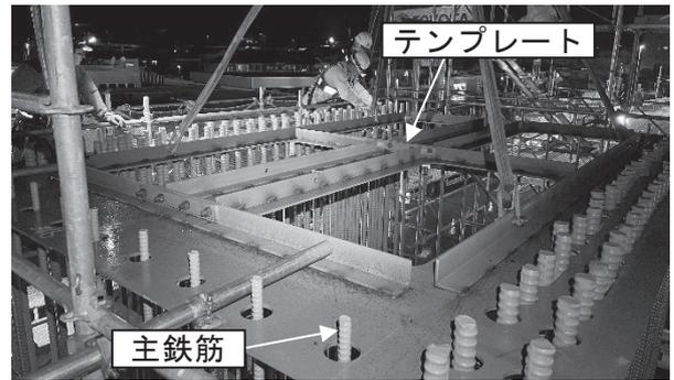
図-9 テンプレート設置状況
