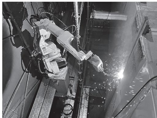
図-7 立向き上進溶接の施工
