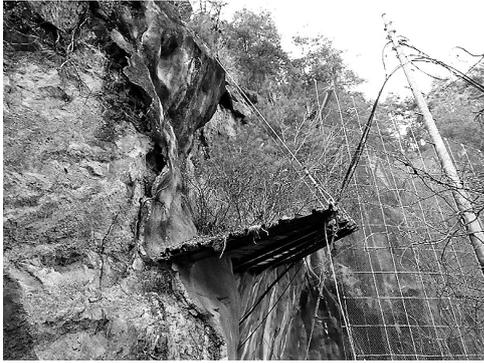
図-5 既設吹付面剥落、防護柵堆積物
