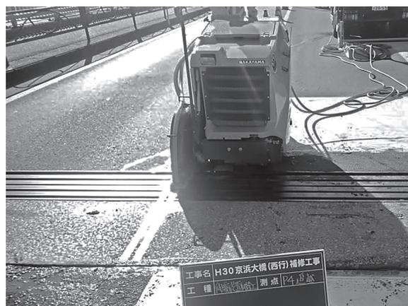
図-5 一次施工と二次施工の分断
