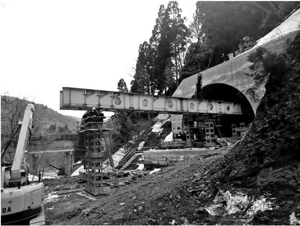
図-2 架設桁送り出し状況
