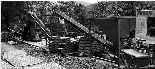
図-3 吹付プラント（従来施工）
