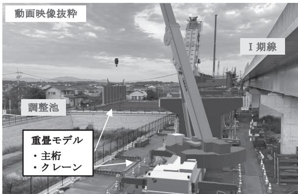
図-2 架設シミュレーションのAR重畳
