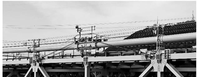
図-4 センターステイ取替工 完成写真
