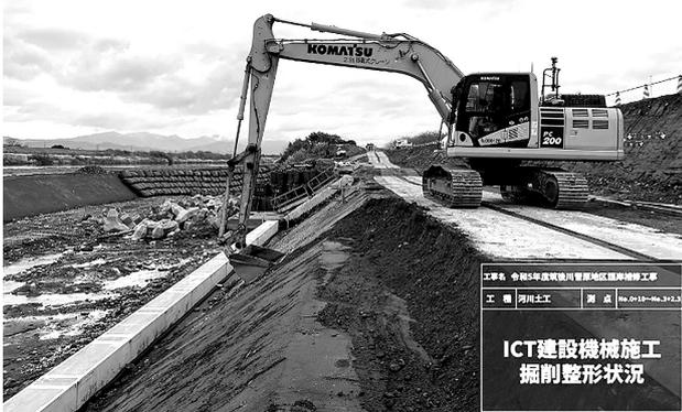
図-2 ICT建設機械による施工状況
