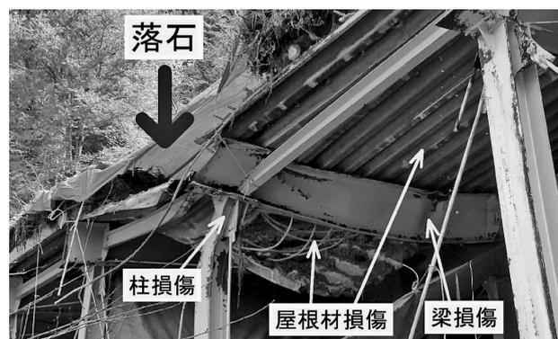
図-1 スノーシェッド損傷状況
