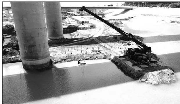
図-3 根固めブロック水中施工状況
