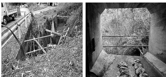
図-5 落下防止柵設置
