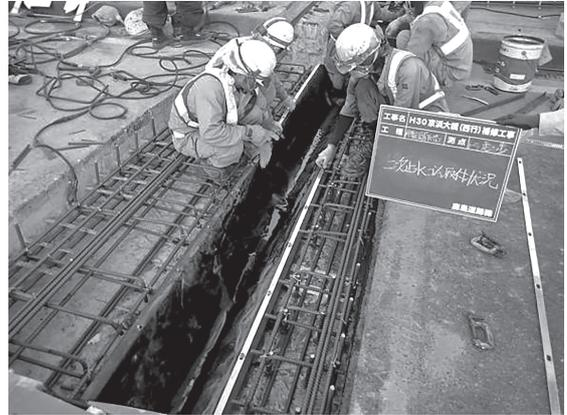
図-10 二次止水材(排水ゴム樋)の取付
