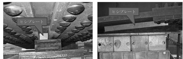
図-4 ヒシプレート使用例
