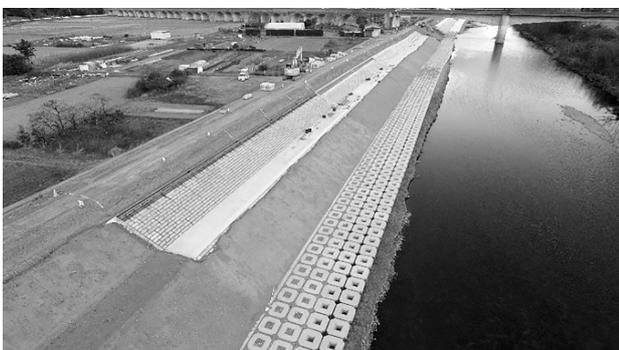
図-3 高水護岸部完了（覆土前）
