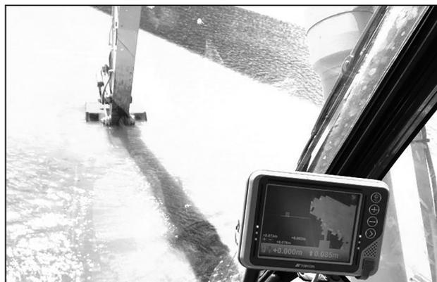
図-4 ICT床掘状況+モニター画面
