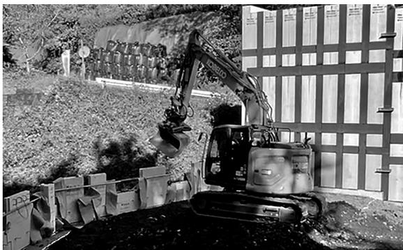
図-8 補強土壁工におけるワンマン施工
