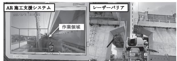
図-4 I期線への接触事故防止措置
