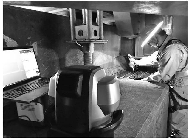
図-6 支承アンカーホール計測状況
