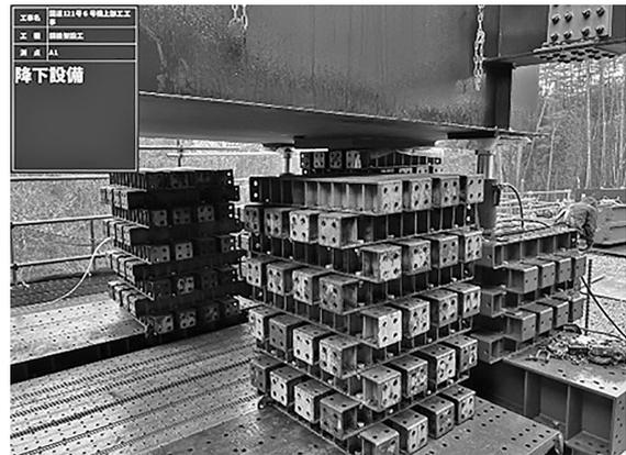
図-2 桁受け設備
